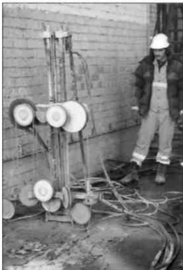
Установка для резки бетона
