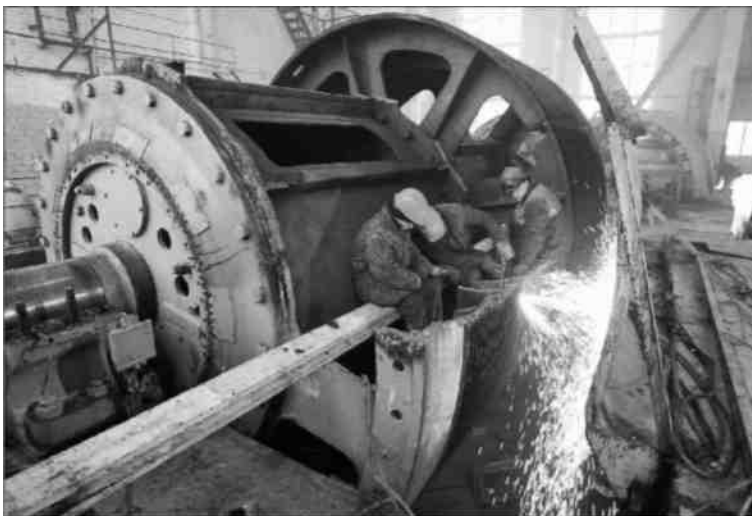
Демонтаж скиповой машины
